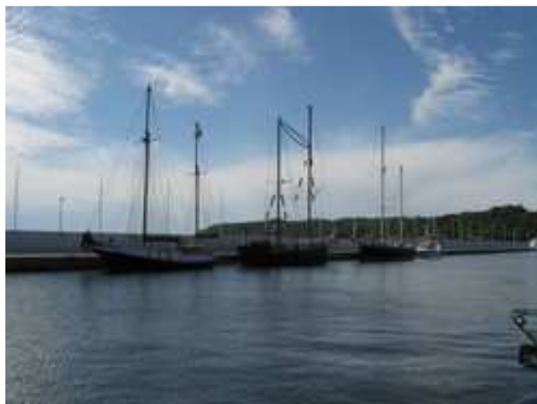
Port żeglarski Gdynia - falochron portowy przebudowany przez Navimor-Invest S.A.
