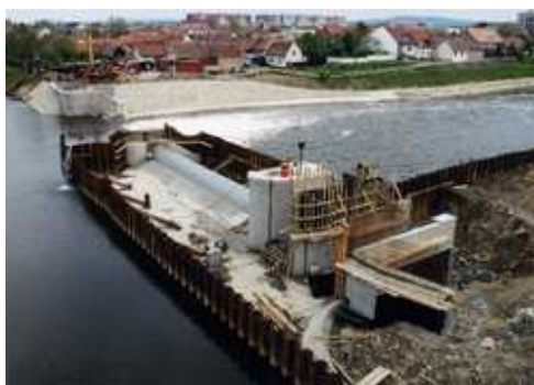
Budowa jazu i elektrowni wodnej Veseli
