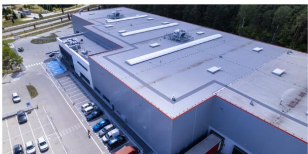
HALA PRODUKCYJNO-MAGAZYNOWA W ŁÓDŹ
