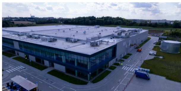
OBIEKT PRODUKCYJNY SIEMIANOWICE ŚLĄSKIE
