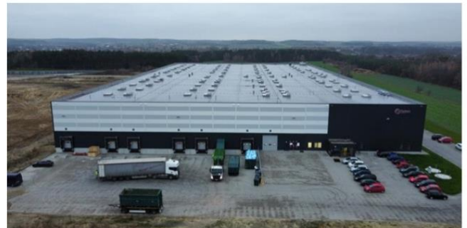
HALA MAGAZYNOWA W RAWIE MAZOWIECKIEJ
