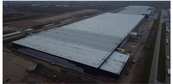
BUDOWA MEDIA EXPERT
