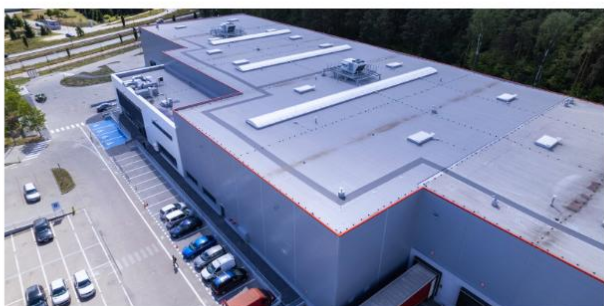
HALA PRODUKCYJNO-MAGAZYNOWA W ŁÓDŹ
