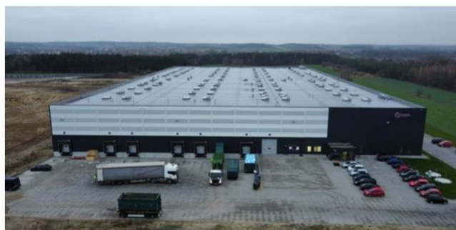
HALA MAGAZYNOWA W RAWIE MAZOWIECKIEJ
