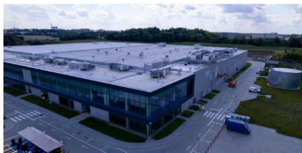
OBIEKT PRODUKCYJNY SIEMIANOWICE ŚLĄSKIE
