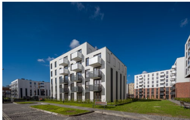
Fundusz Mieszkań dla Rozwoju, Wrocław, ul. Kolejowa, 469 mieszkań
