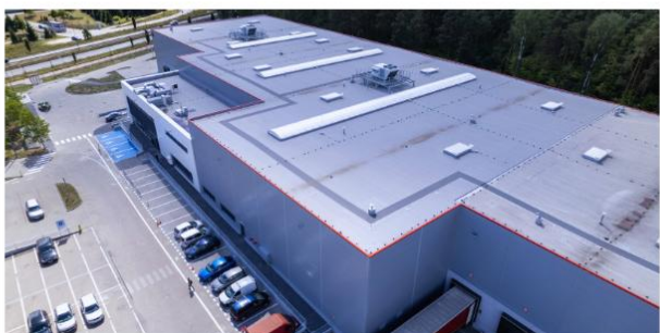
HALA PRODUKCYJNO-MAGAZYNOWA W ŁÓDŹ
