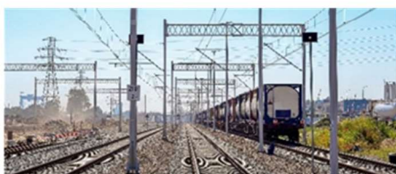
PGE Energetyka Kolejowa. Budowa podstacji trakcyjnej PT Zduńska Wola Karsznice. Wartość 37 mln PLN
