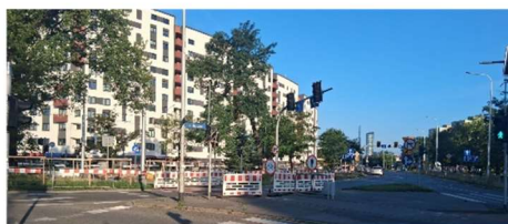
Gmina Wrocław. Remont torowiska Bardzka we Wrocław. Wartość 10 mln PLN
