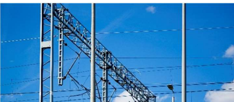
PGE Energetyka Kolejowa. Budowę podstacji trakcyjnej PT Knyszyn i RS Knyszyn. Wartość 22,7 mln PLN
