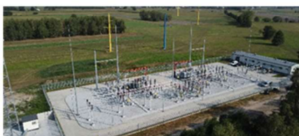
Polskie Sieci Elektroenergetyczne. Rozbudowa rozdzielni w stacji 220/110 kV Adamów dla przyłączenia BGP Adamów. Wartość 34 mln PLN
