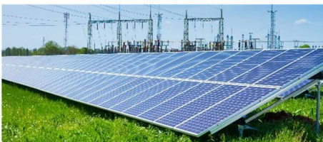
Polskie Sieci Elektroenergetyczne. Rozbudowa i modernizacja rozdzielni 220 kV w stacji 400/220/110 kV Pątnów. Wartość 17,7 mln PLN
