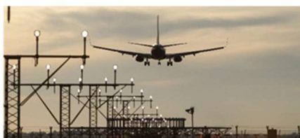
Port Lotniczy Szczecin-Goleniów. Wykonanie systemu pomocy nawigacyjnych na lotnisku. Wartość 39 mln PLN
