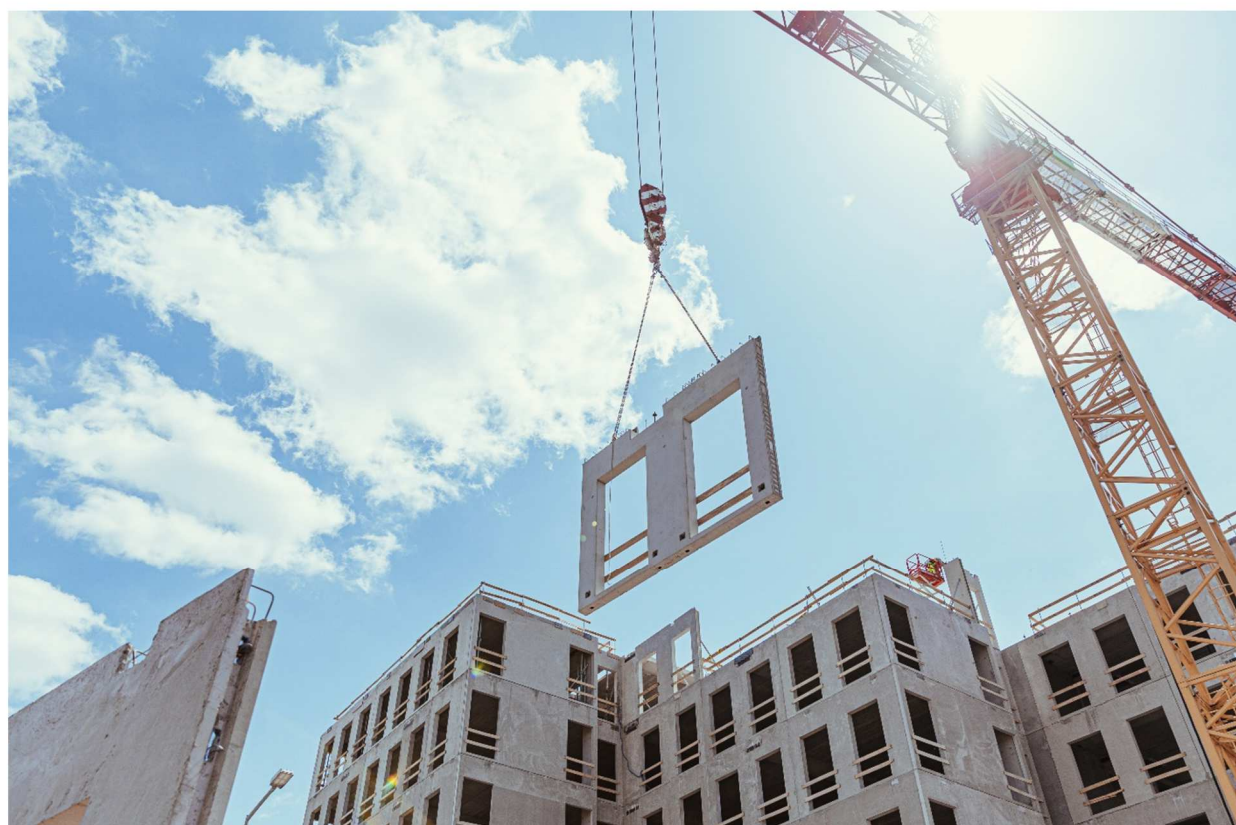
Montaż elementów prefabrykowanych na placu budowy, Selgros Poznań
