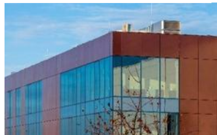
Fot 6 Fasada wentylowana
