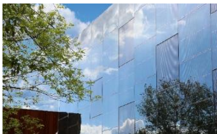
Fot 6 Fasada słupowo-ryglowa
