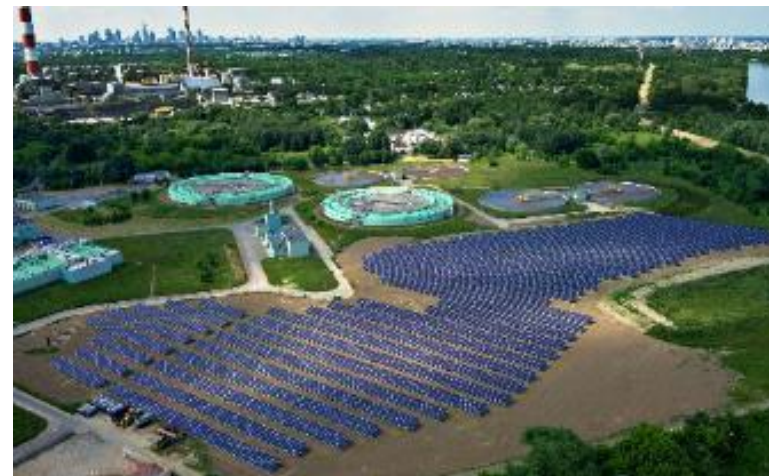
Fot 8 Elektrownia fotowoltaiczna
